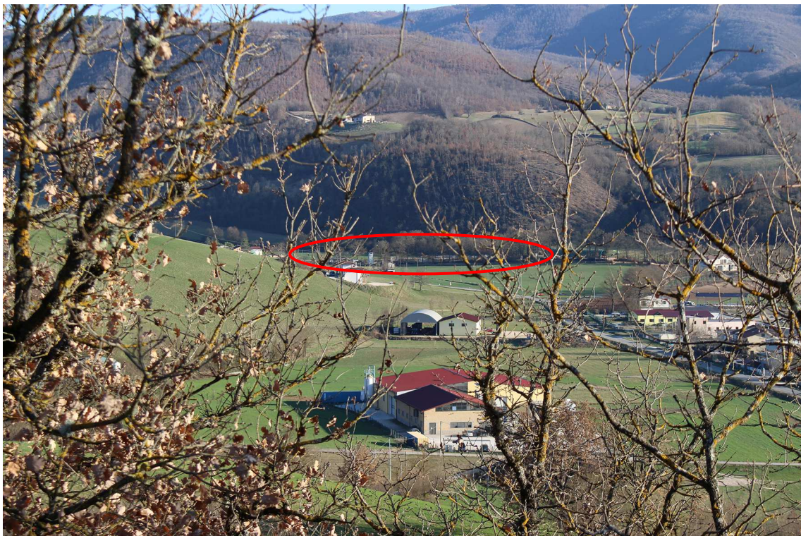
Foto n° 2 - scattata da strada per Colforcella – Sito di intervento ex-post
