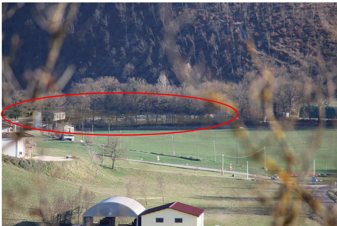
Foto n° 4 - scattata da strada per Colforcella – Sito di intervento ex-post
